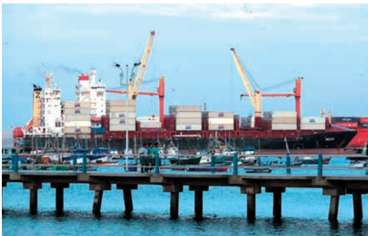
Foto N° 53: Infraestructura tradicional portuaria de Lambayeque
