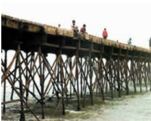
Foto N° 31: Antiguo muelle de Éten
