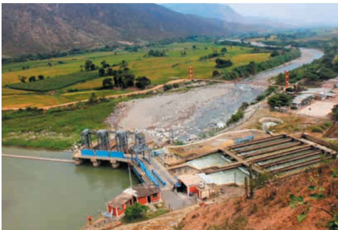
Foto N° 5: Bocatoma Raca Rumi - Perú
