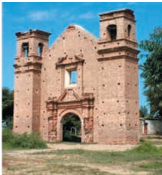
Foto N° 30: Convento de San Pedro y San Pablo de la orden de los mercedarios en el valle de Santiago de Miraflores de Zaña, edificado a inicios del siglo XVII
