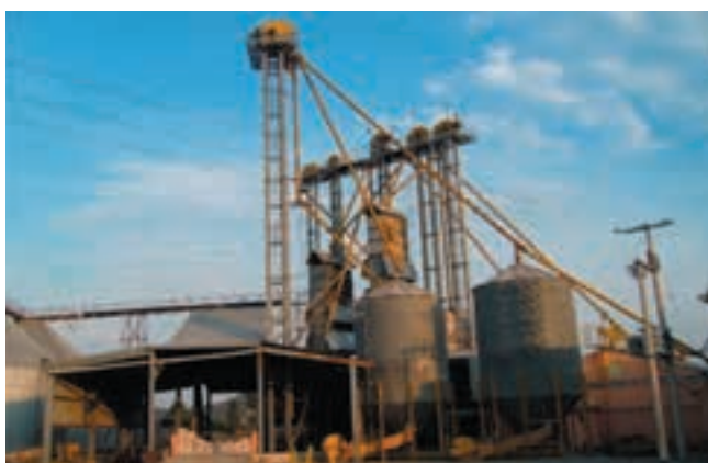
Foto N° 10: Infraestructura industrial, procesamiento de arroz en Lambayeque
